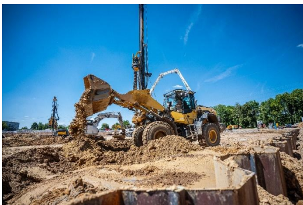
(2) Starke Partnerschaft: Bauer Resources und Bauer Spezialtiefbau arbeiteten Hand in Hand, um die Baugrube termingerecht und passgenau fertigzustellen.
