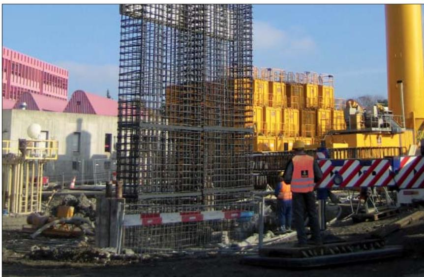
Das Los 37.20 liegt bei Chêne-Bourg. Hier werden für die mehr als 1 km lange Tagbaustrecke Foron 24.500 m<sup>2</sup> gegreiferte Schlitzwand von Dezember 2013 bis Februar 2015 hergestellt.
