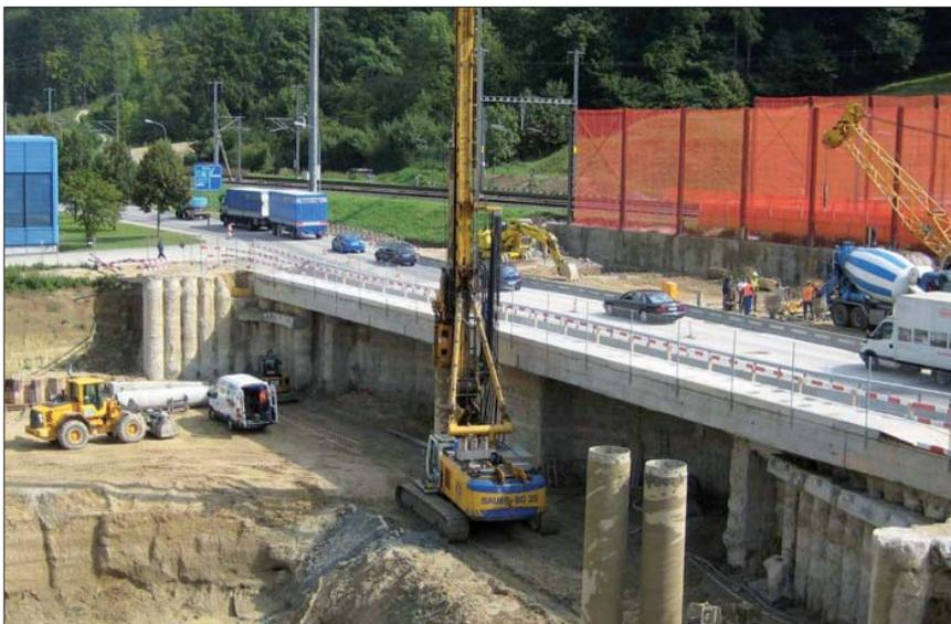
Der erste Dichtblock auf der Hälfte der Strecke wurde in einer Kombination aus gefrästen Lamellen im CSM-Verfahren und gegreiferten Schlitzwandlamellen ausgeführt. Der Dichtblock hat ein Volumen von 19.320 m<sup>3</sup>. Der zweite Dichtblock für den Durchschlag der Tunnelbohrmaschine in Brüggmoos wurde aus insgesamt 108 unbewehrten, in fünf Reihen überschnittenen Grossbohrpfählen mit einem Durchmesser von 1.500 mm hergestellt.
